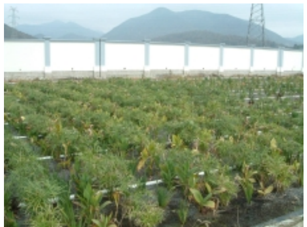
Pflanzenkläranlage im November 2004
