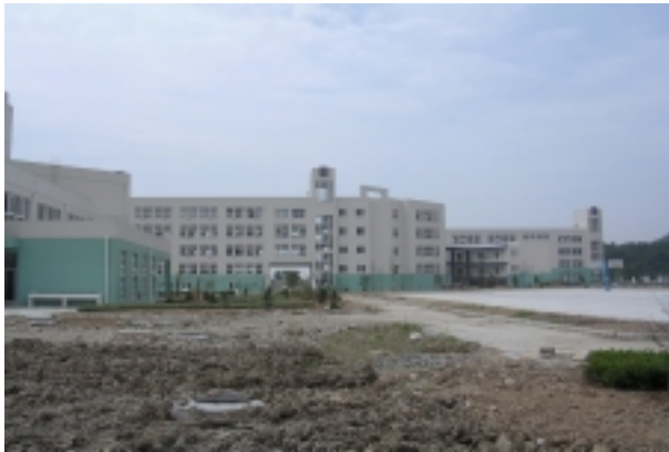
Außenanlagen im Rohbau Juni 2004
