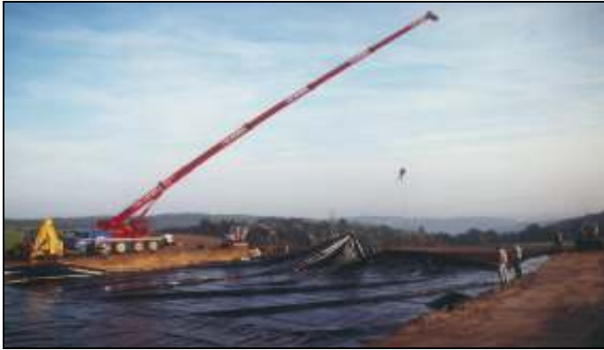
Folienabdichtung gegen unkontrolliertes Versickern
