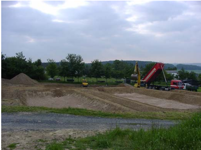
Herstellen der Erdbecken für die Bodenfilter
