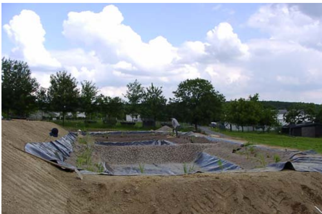
Puffer- und Speicherteich mit Kiesriegel im Bau
