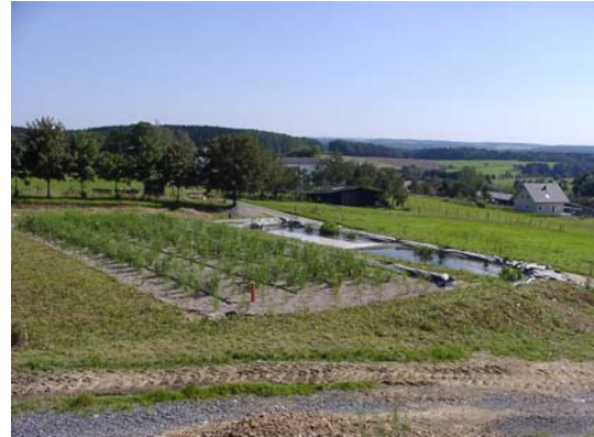
Bodenfilter kurz nach Inbetriebnahme
