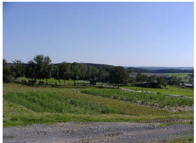
Teich-Bodenfilteranlagen im August 2004
