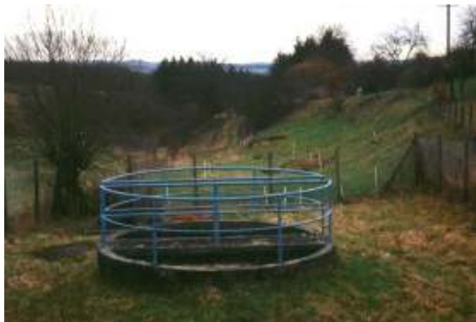
Bestehendes Emscherbecken wurde ins neue Konzept eingebunden
