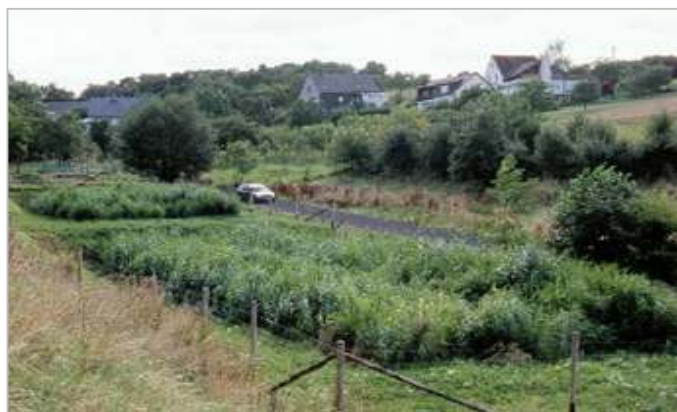
Pflanzenkläranlage paßt sich dem Landschaftsbild an – Juli 2001
